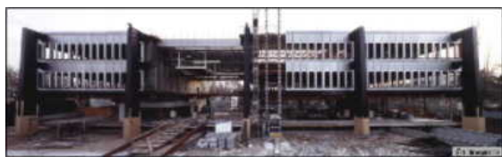
Varsovie : Ambassade France en rénovation
