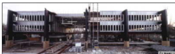
Varsovie : Ambassade France en rénovation
